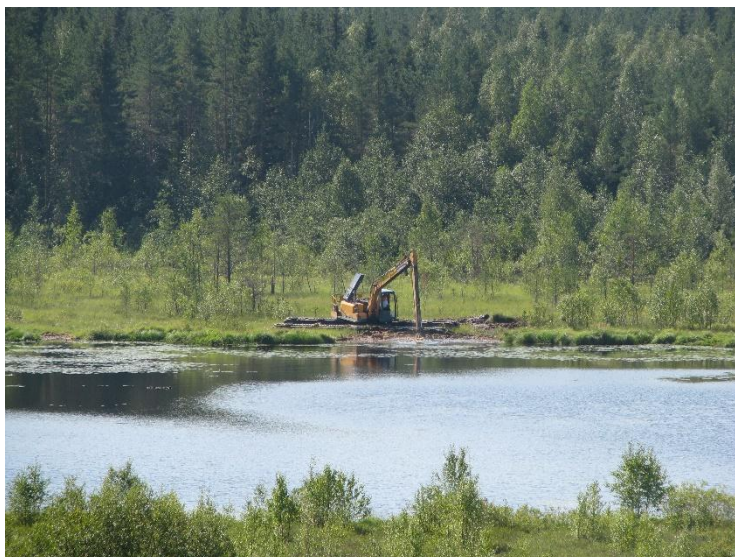
Kuva 8 Kelluva kaivinkone Kurkelanjärvellä. Kuvannut Matti Leiviskä 5.8.2014.
