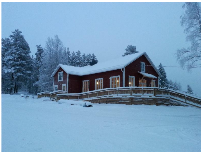
Kuva 7 Peruskorjattu Kylätalo tarjoaa entistä paremmat tilat erilaisten juhlien ja tapahtumien järjestämiseen. Kuvannut Matti Leiviskä 29.11.2016.
