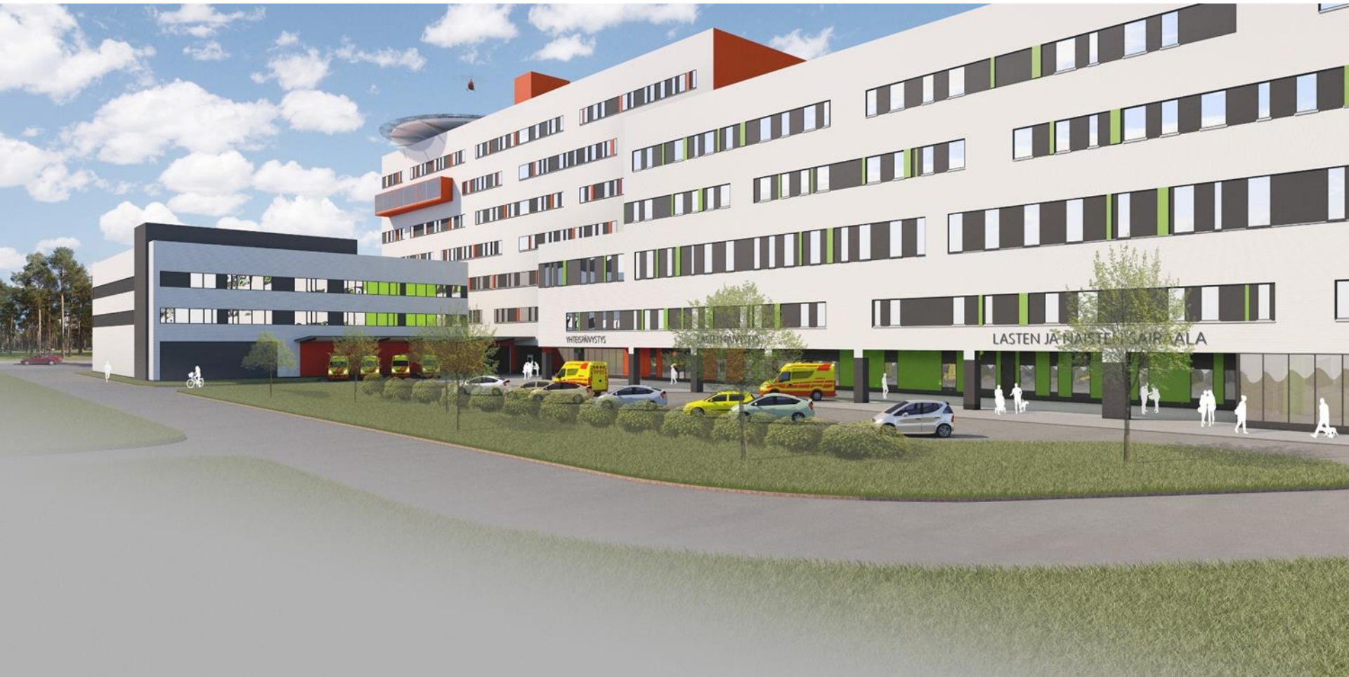
II-vaiheen sekä Lasten ja naisten sairaalan sisääntulopiha
